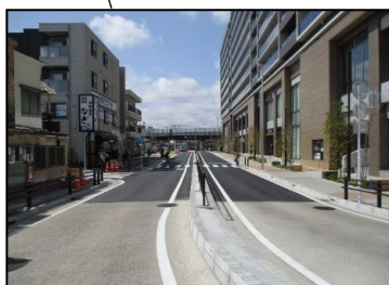
拡幅された道路
