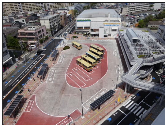
大船駅北口 駅前広場(栄区)
