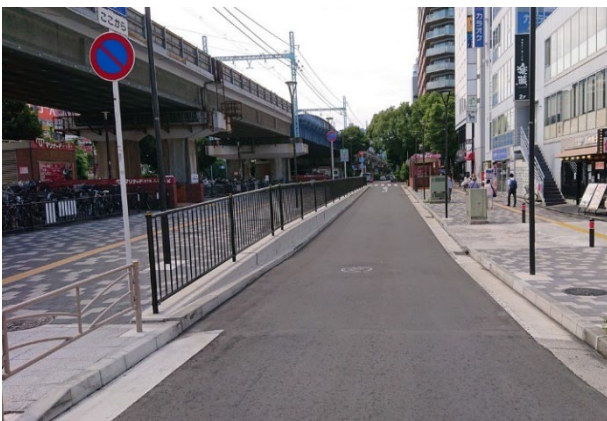
JR 関内駅北口周辺道路 (写真1)
