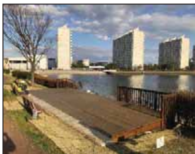
ふなだまりウッドデッキ (金沢区富岡東)
