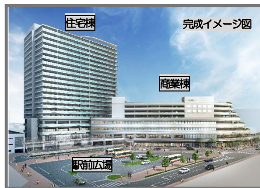
大船駅北第二地区 市街地再開発事業 (事業中)
