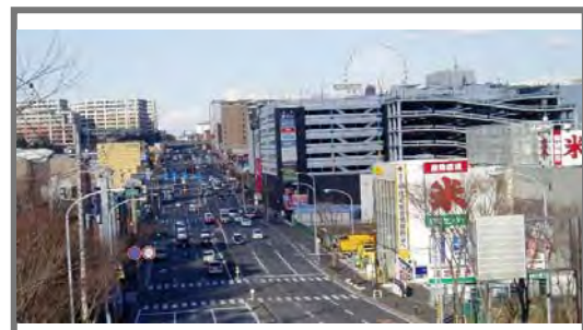
横浜北部新都市中央地区（港北NT） 土地区画整理事業（完了）
