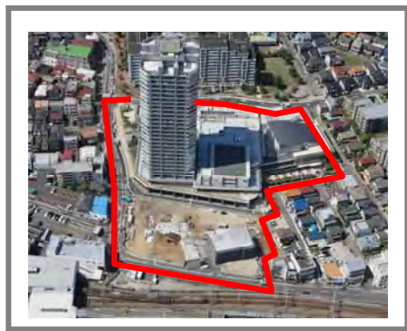
長津田駅北口地区 市街地再開発事業（施行中）
