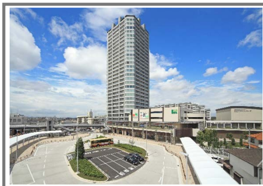
長津田駅北口地区 市街地再開発事業（完了）
