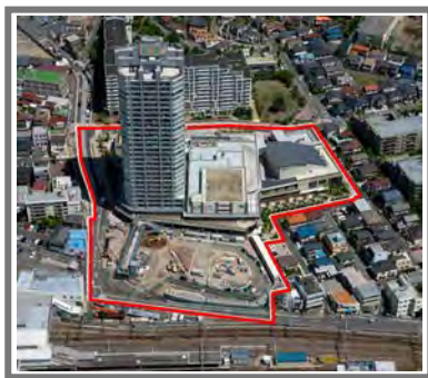
長津田駅北口地区 市街地再開発事業（施行中）
