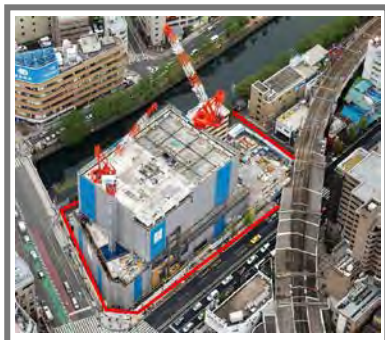
日ノ出町駅前A地区 市街地再開発事業（施行中）
