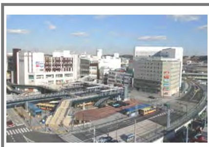
戸塚駅西口第1地区 市街地再開発事業（完了）
