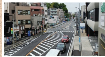
設置した横断歩道(令和8年4月撮影)
