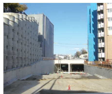
完成擁壁(西側)
