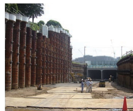
擁壁工事中(東側)
