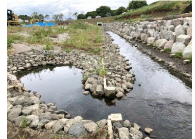
整備後(自然石による護岸やトンボ等のすみかとなるたまり池「ワンド」)
