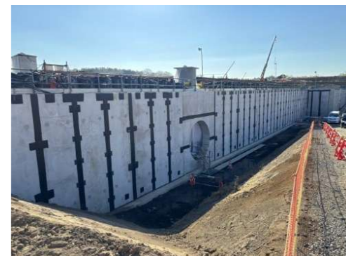
【相沢川調整池(地下式)の工事状況】
