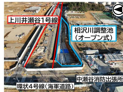
【上川井瀬谷1号線等の工事状況】
