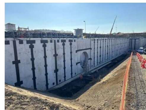
【相沢川調整池(地下式)の工事状況】
