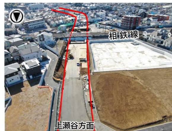
【瀬谷地内線全景】
