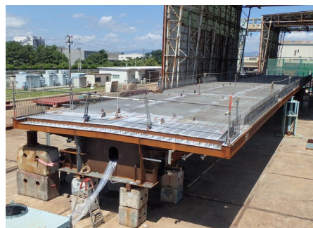
【⑤工場における橋桁製作状況】
