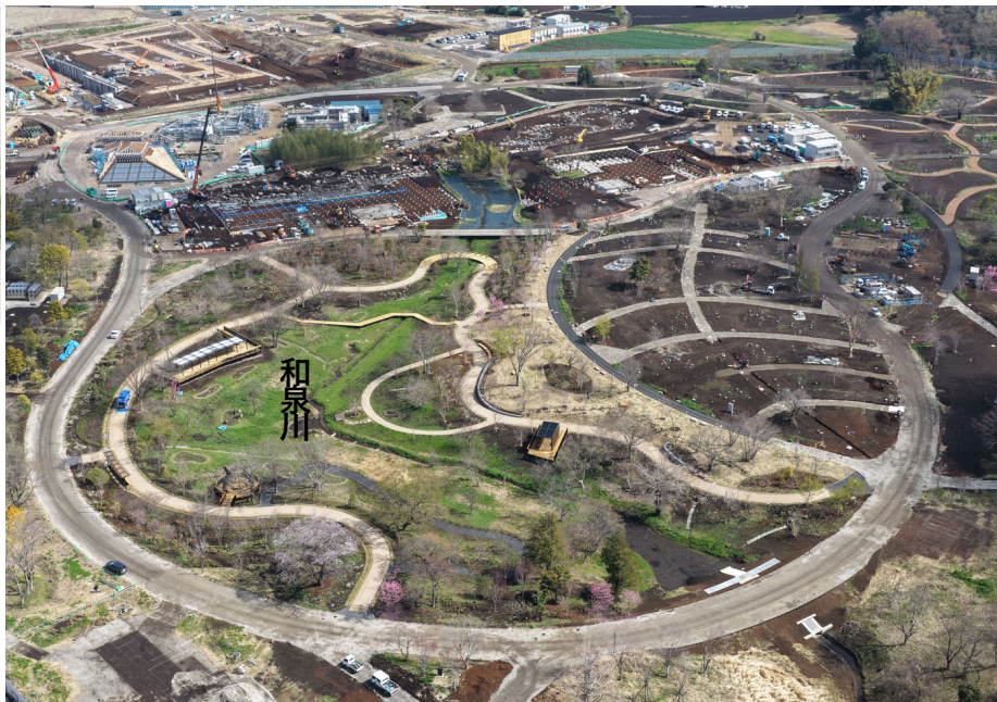
〈①和泉川周辺の工事状況〉
