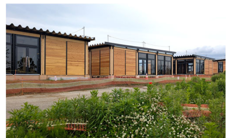
【協会の建築工事(カフェ、コンビニ等)】 ※外装工事は今後
