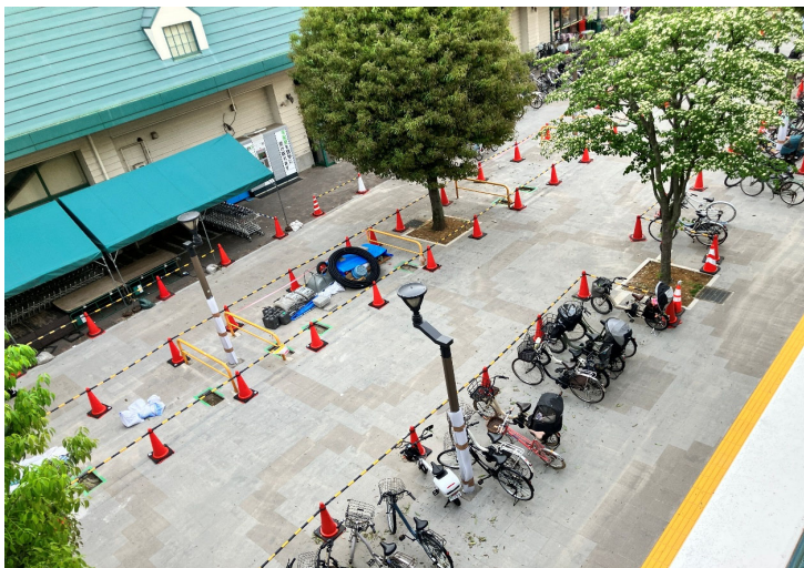
保水性舗装による舗装整備の状況(瀬谷駅北口駅前広場)
