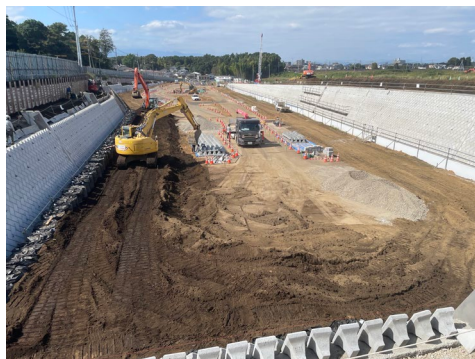
【写真①：大門川調整池の壁面工事】
