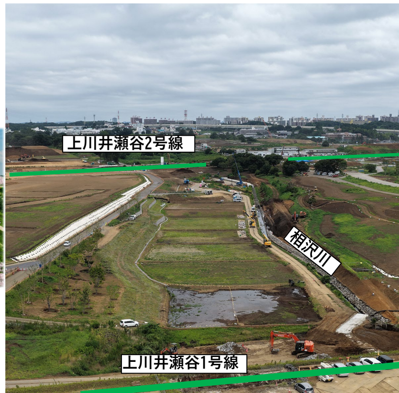
〈①相沢川周辺の工事状況〉
