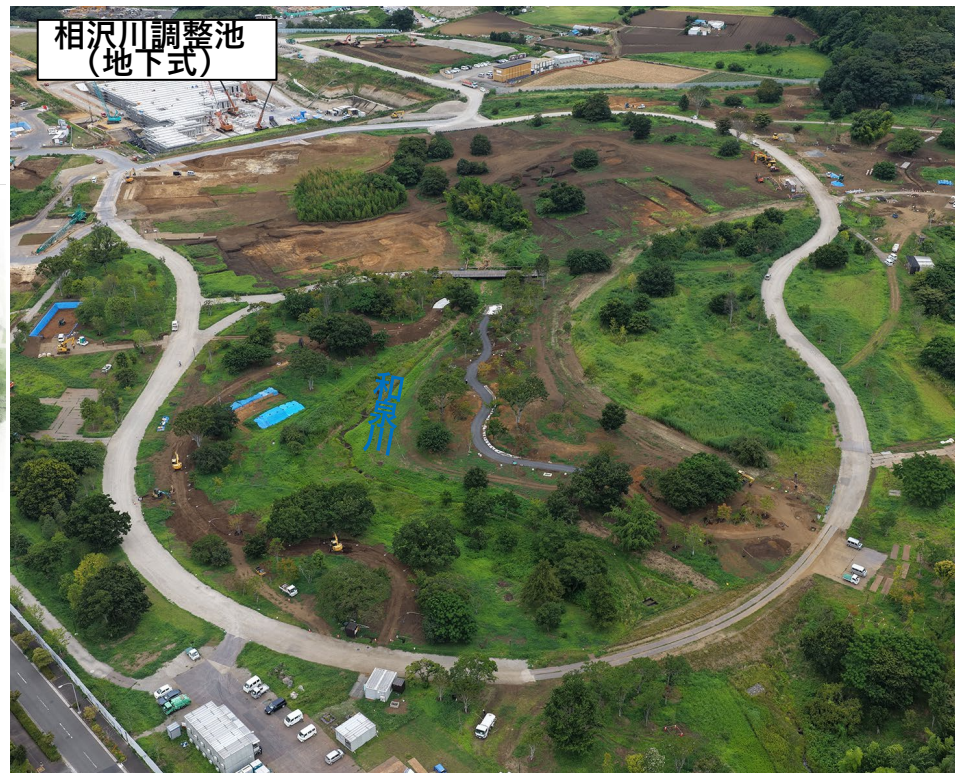
〈①和泉川周辺の工事状況〉
