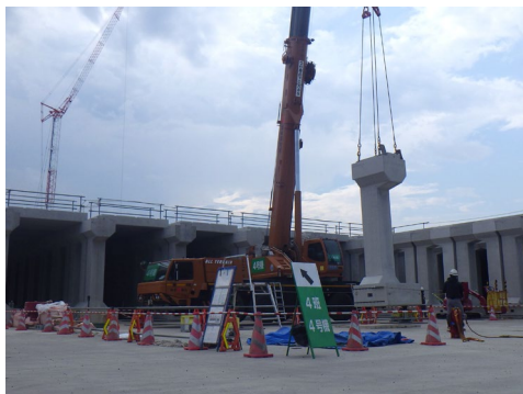
【写真②：相沢川調整池（地下式）の コンクリートブロック据え付け工事】
