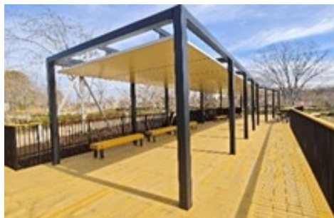
【③整備済の休憩施設】
