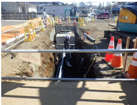
電線共同溝工事設置
