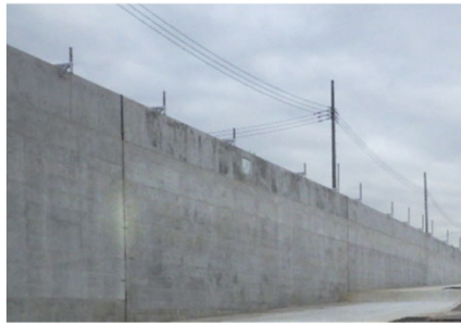
コンクリート施工後(他事例)
