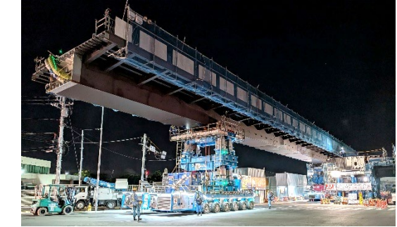
多軸特殊台車（ドーリー）による架設
