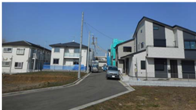
新しく整備された区画道路
