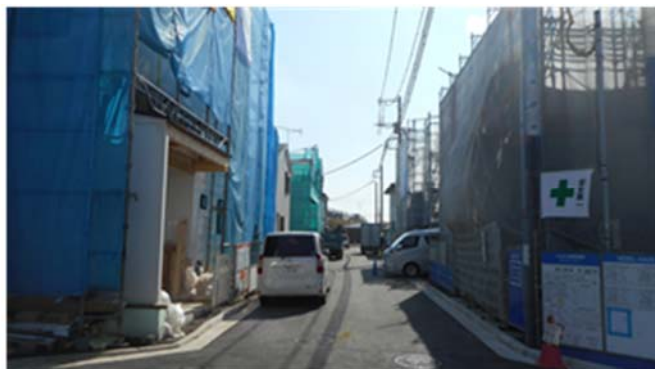
建築工事が進行中です！
