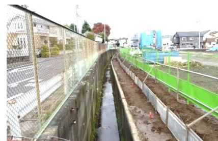
着工前の状況
