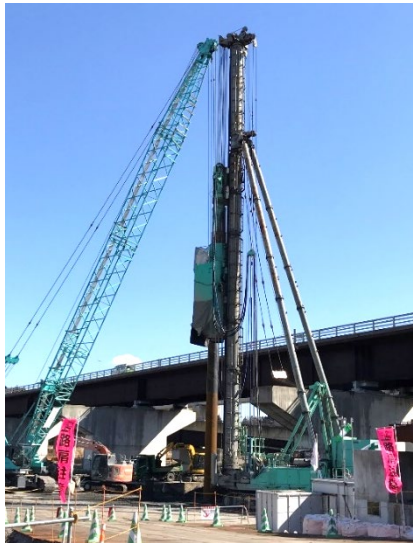
① 杭打ち機
