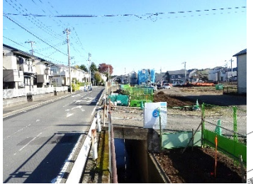
既設占用橋撤去 (令和5年3月頃)
