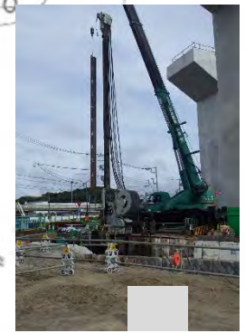
杭打ち工事 (イメージ)
