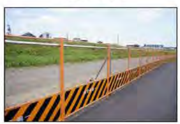
(工事用車両通路への立入防止用) (自治会館前の広場に設置)
