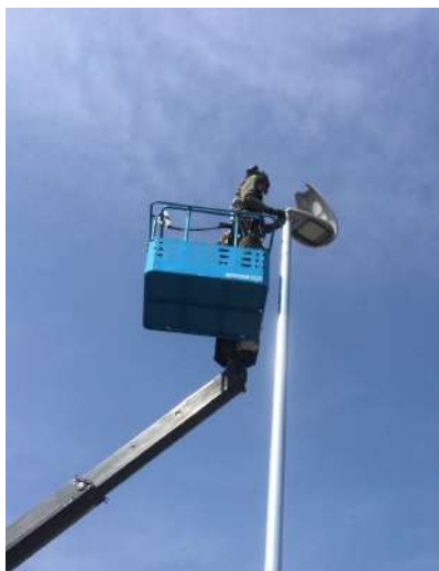
【施工中の様子】 灯具設置
