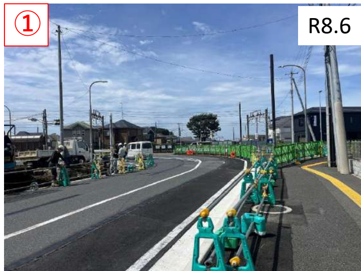
車道拡幅状況
