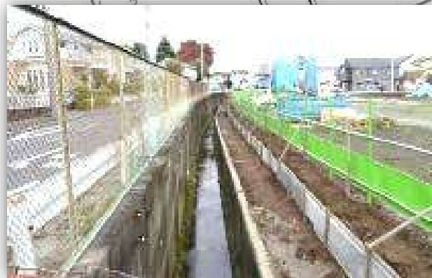
着工前の状況（開水路）
