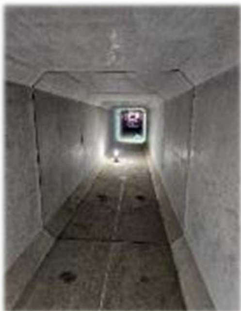
ボックス内部の状況
