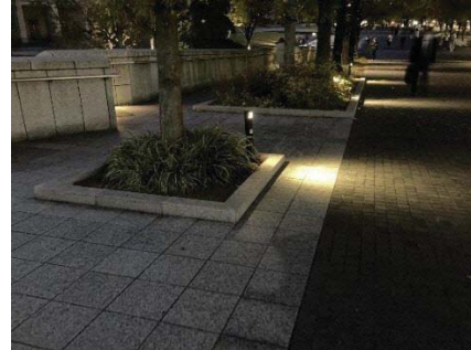
グレアに配慮し足元を照らす照明
