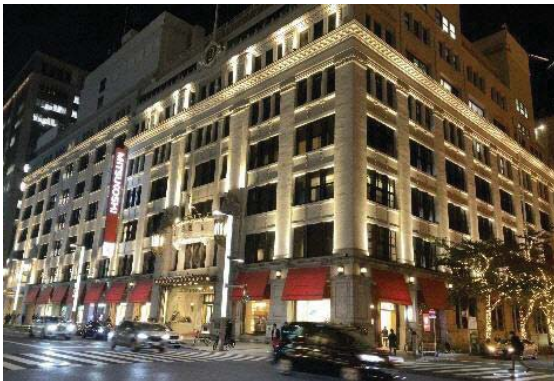
構造を生かした照明演出
