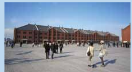
みなとみらい21新港地区
