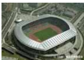
横浜国際総合競技場 (日産スタジアム)
