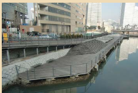
■ウッドデッキのボードウォークが整備され、水辺を感じることのできる空間を創出しています（横浜市中区）
