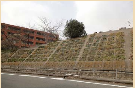
■ 擁壁に植栽ブロックを用いることで圧迫感や威圧感を軽減しています（横浜市長谷区）
