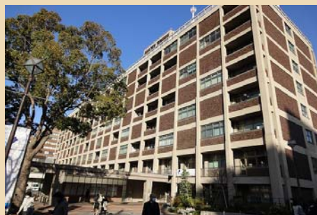
■茶系のタイルと開口部で様々な組合せをつくることで単調な壁面とならないよう工夫されています（横浜市中区）
