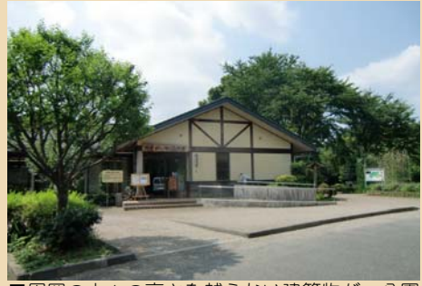
■周囲の木々の高さを越えない建築物が、公園の景観に馴染んでいます（東京都町田市）
