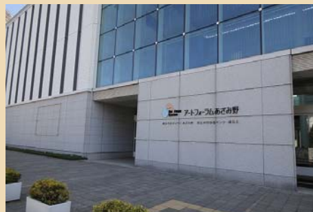
■外壁の低層部に石材を用いることで落ち着きを感じることができます（横浜市青葉区）
