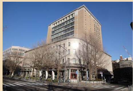
■高層部を後退させることで、通りからの圧迫感の軽減や歴史的建造物の趣を阻害しないよう配慮しています（横浜市港中区）
