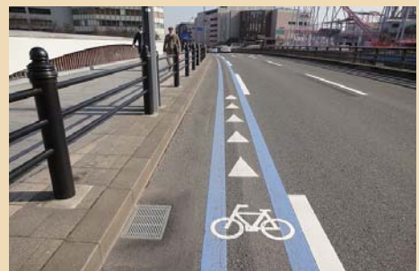
■ 自転車レーンに落ち着いた青色を使用するとともに、塗装部分を必要最小限に抑えています (横浜市西区)
