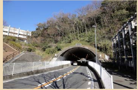
■坑口部壁面のコンクリート面を少なくすることで、緑豊かな印象を与えています（横浜市金沢区）
