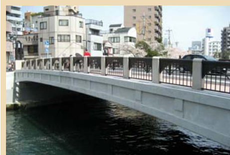
■装飾されていない桁側面が、高欄の意匠を引き立てています（横浜市中区）
