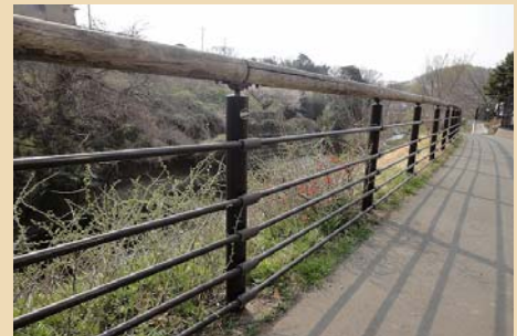
■ 柵に自然素材を用いることで、周辺の自然に馴染んでいます（横浜市栄区）
