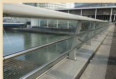
■ガラスと最小限の横棧でシンプルにデザインされた高欄が高質な街並みを演出しています（横浜市中区）
