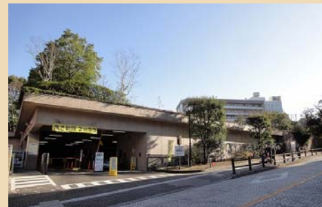
■駐車場の屋上や壁面を緑化し、潤いのある景観を創出しています（横浜市西区）
