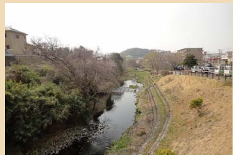
■周辺の自然景観と調和した緑溢れる護岸となっています（横浜市栄区）
