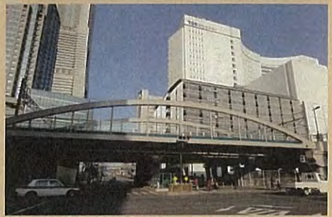
■彩度を抑えた色彩を用いることで、周囲の景観を阻害することなく調和しています（横浜市中区）
