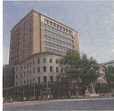
【横浜情報文化センター（一部）】 一部を保全しながら高層棟を整備。歴史的建造物躯体は再アルカリ化工事実施。
