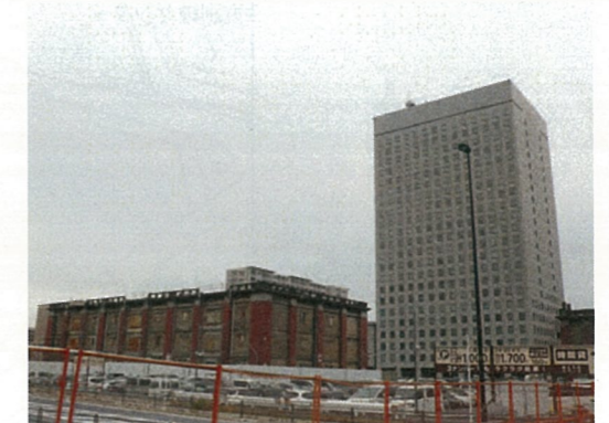
j. 栄本町線から敷地と第二合同庁舎を見る
