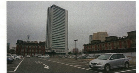
i. 区画道路から敷地とアイランドタワーを見る
