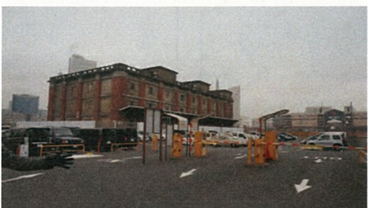
d. 栄本町線から敷地とワールドポーターズを見る
