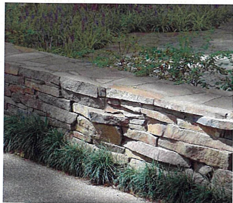
鉄平石小端積み
