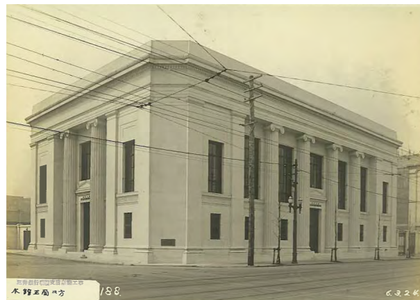
交差点側全体（竣工当時）
