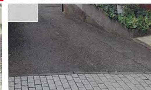
【既存】アスファルト舗装
