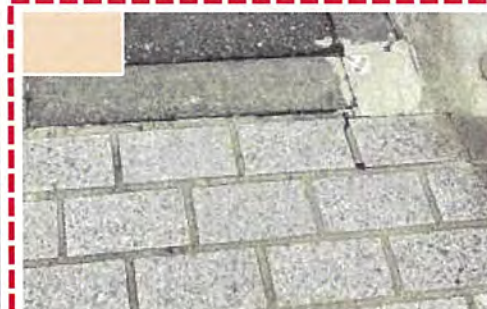
【既存】歩道タイル舗装
