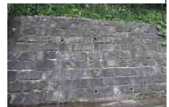
重力式擁壁の表面にブラフ積の石材を化粧材として貼り付けている例
