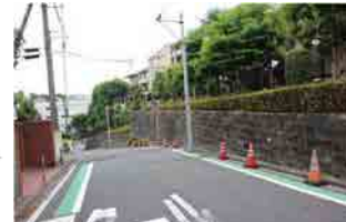
RC 擁壁の前面にブラフ積を積み直して緊結している例
