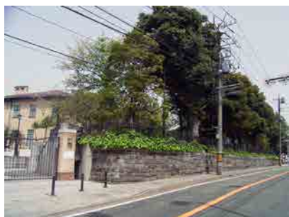
ブラフ積み擁壁上部を緑化している例
