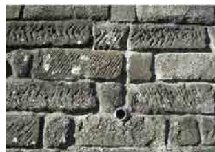
重力式擁壁の表面にブラフ積の石材を化粧材として貼り付けている例
