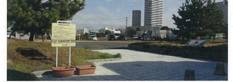
台場公園 地下には神奈川台場の遺構が埋没しており一部石積みが見えている
