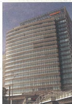
日産本社ビル
