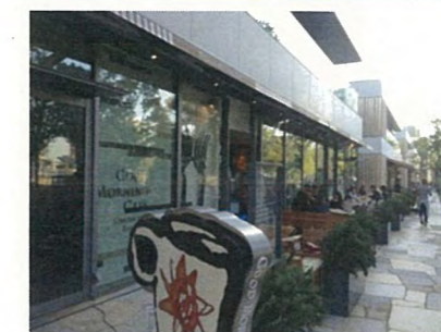
開放性の高いガラスのファサード
