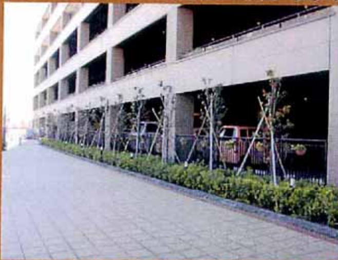
[高木の列植により道路から駐車場を遮蔽]
