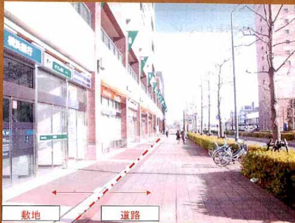
[敷地と道路との一体的な舗装]
