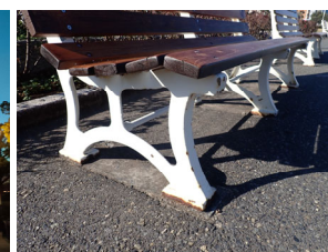
ベンチは老朽化が進行している
