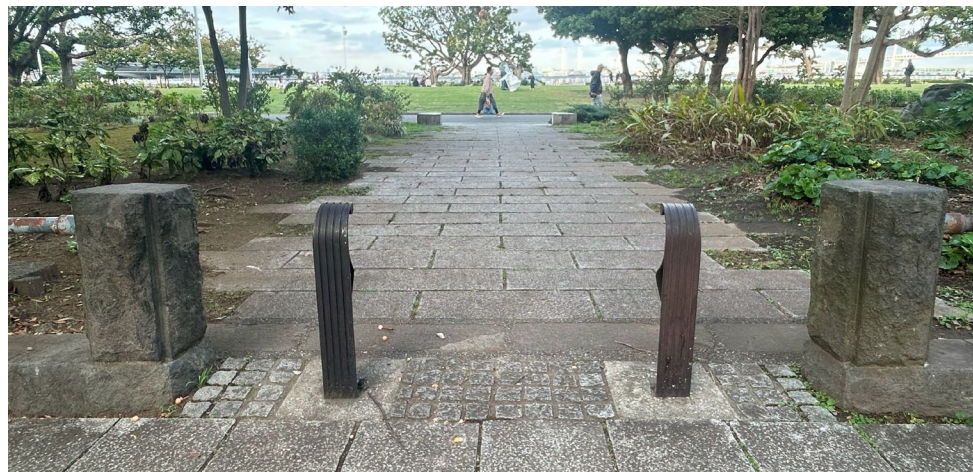
既存入口と石材舗装の現況
