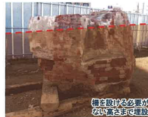
現在の横浜銀行協会・旧横浜銀行集会所の前身にあたる建物で、明治38年に建設され、関東大震災で被災・倒壊したものの柱部。
