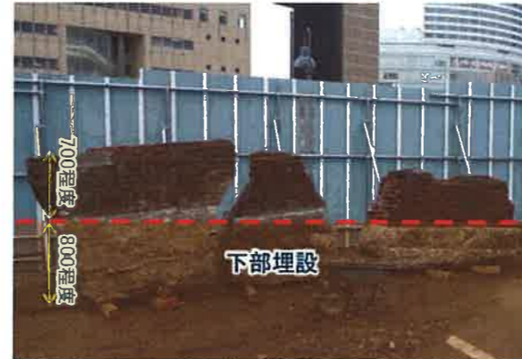
明治3年ごろに、燈台寮の試験場として建設されたレンガ造の建物基礎の一部が出土したもの。
