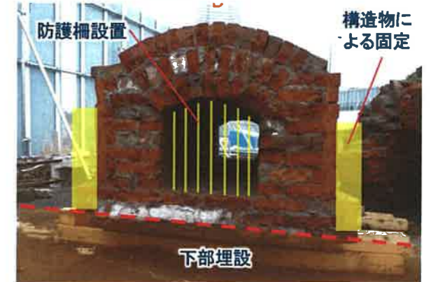
明治3年ごろに、燈台寮の試験場として建設されたレンガ造の建物基礎下部に敷設されていた排水施設の一部が出土したもの。
