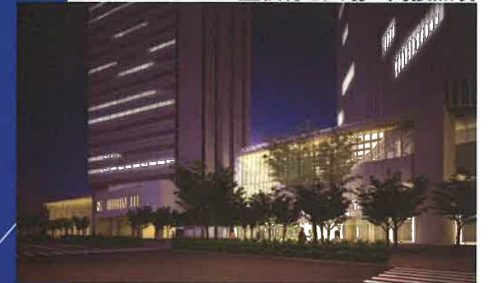
③ 開かれた市庁舎を象徴する屋根付き広場の間接照明
