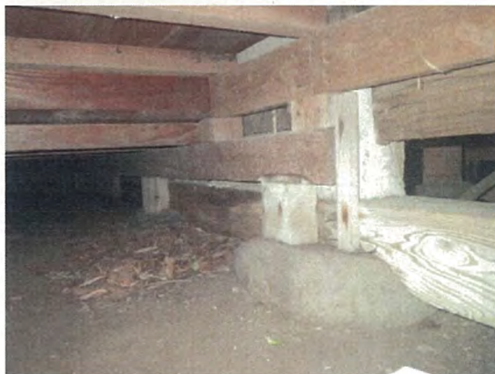
写真3-1 主屋 玉石基礎（西）
