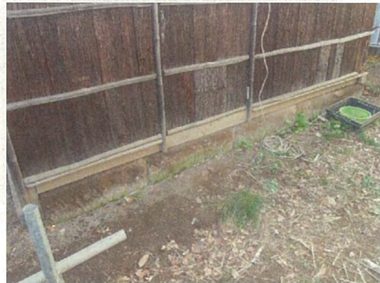
写真 3-22 東屋 切石布基礎（東）
