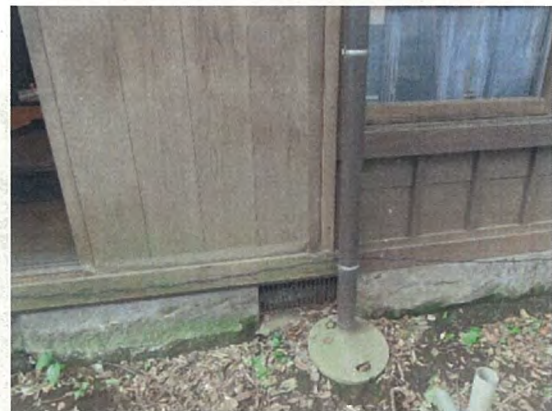
写真3-2 主屋 切石布基礎（北）
