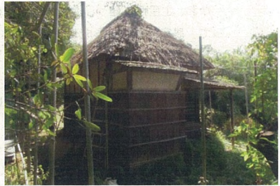
写真 2-11 東屋北西外観
