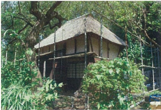
写真 2-10 東屋南東外観
