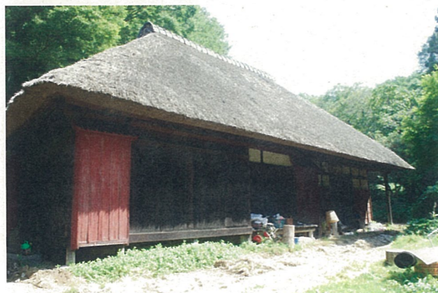
旧藤本家住宅主屋：南側外観 平成25年9月撮影
