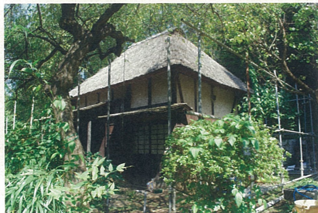
東屋：南東側外観 平成25年9月撮影
