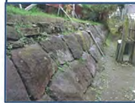
住宅が立ち並ぶ一角にある石垣露出部分
