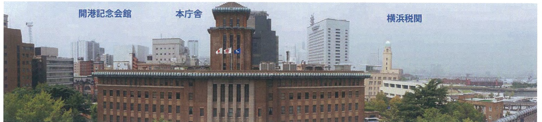
既存分庁舎から眺めることのできる横浜三塔
