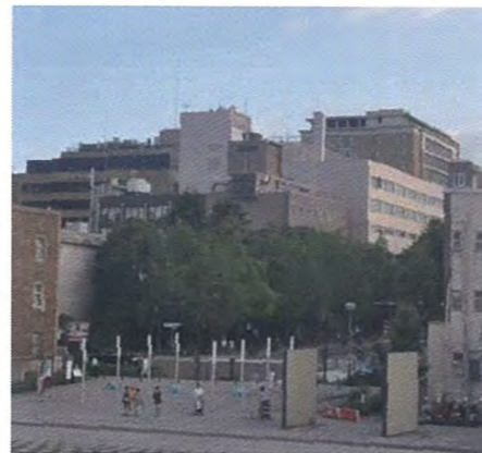
設備配管が露出し見え隠れする現況の景観
