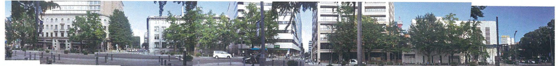
連続立面写真(敷地側)
