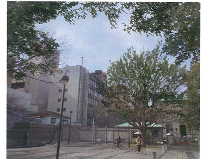
設備配管が露出した現況の景観
