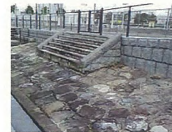
大岡川河口護岸荷揚場
