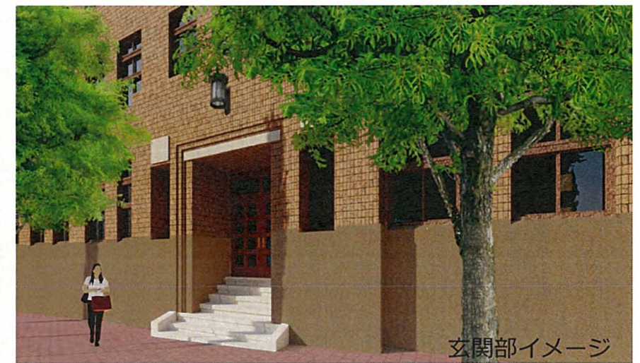
解体前玄関部
