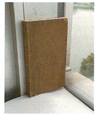
万国橋ビル外壁タイル
