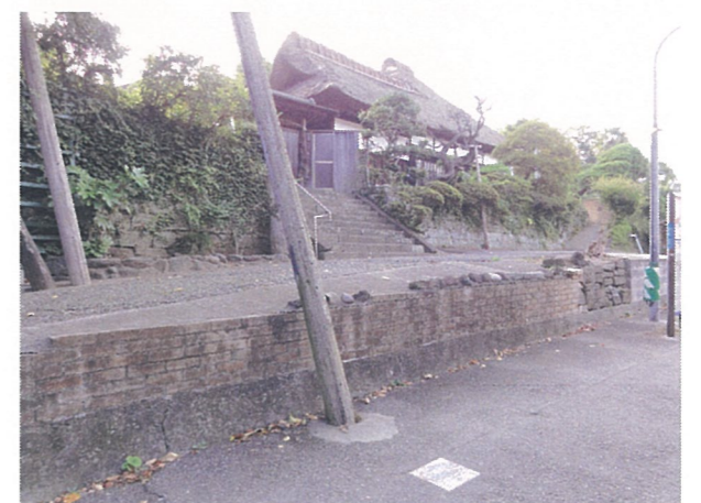
⑦敷地東側
