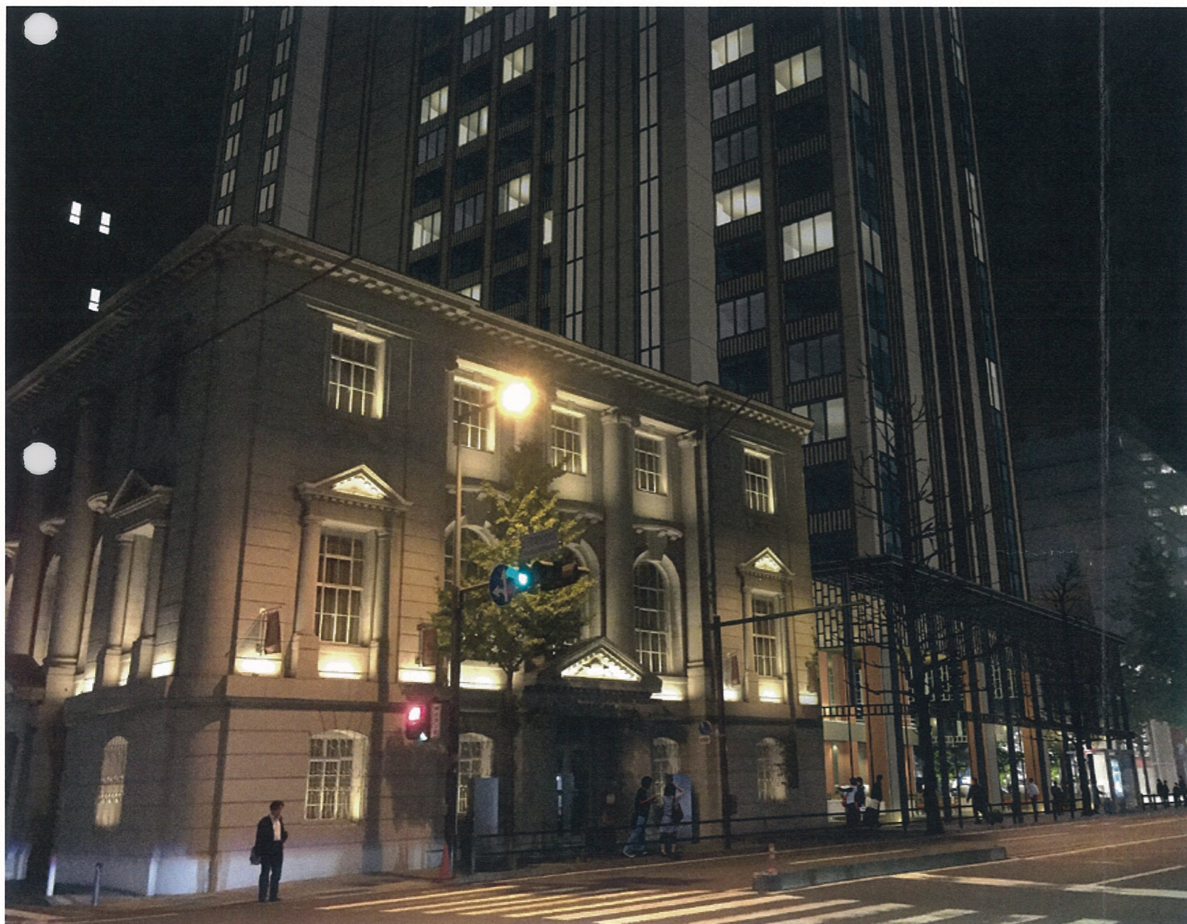
本町通り、露亜銀行側より見る
